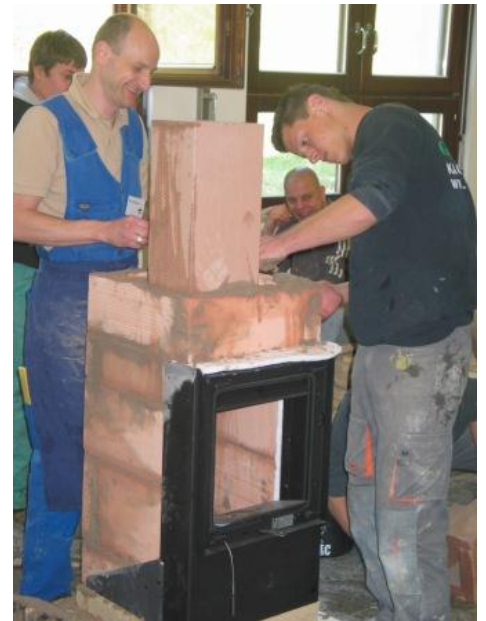
õ Verwendung des Lehmputzes õ õ ..für das Bildõ õ õ undõ õ für den Bau eines Ofensõ õ
